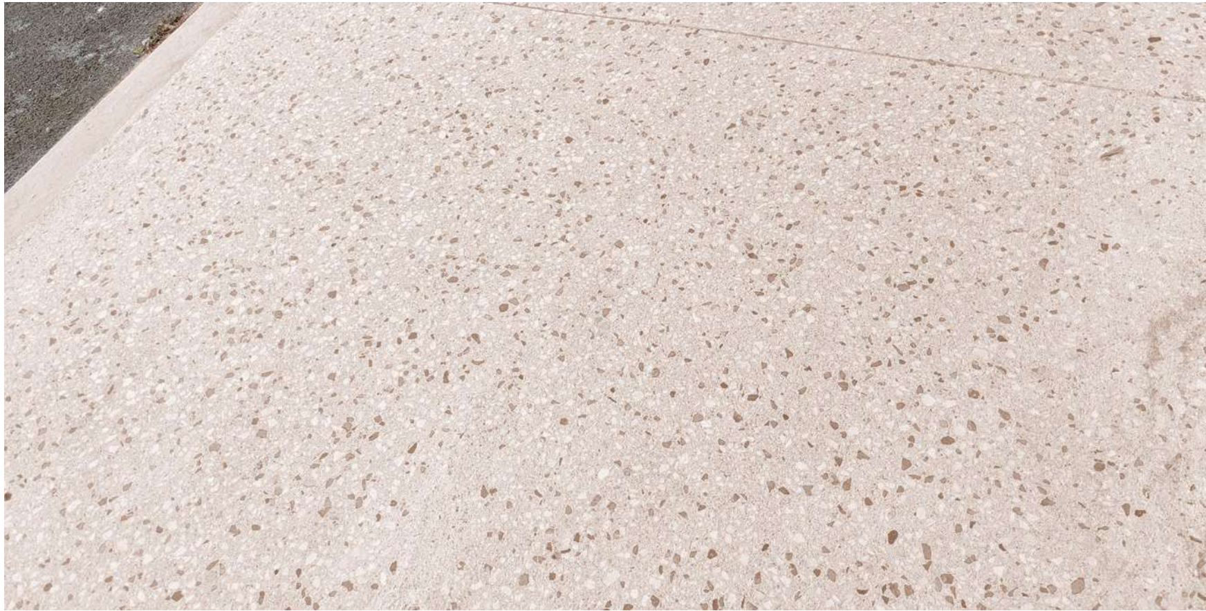
Béton désactivé poncé
