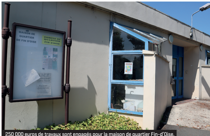
250 000 euros de travaux sont engagés pour la maison de quartier Fin-d'Oise.
