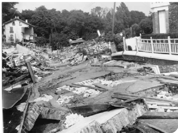
Figure 20 : Effondrement généralisé à Clamart
