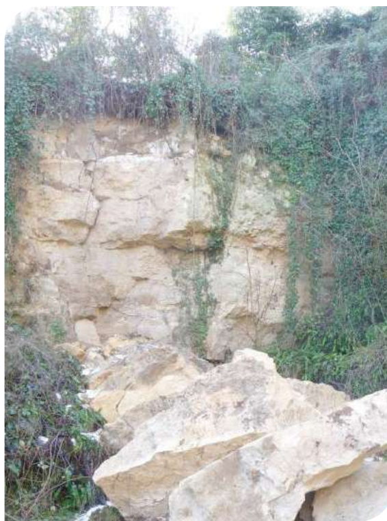
Figure 21 : Effondrement de front rocheux à Villennes-sur-Seine
